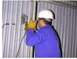
Inspección de paredes de calderas
