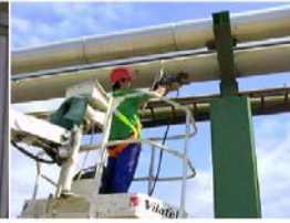
Inspección de tuberías
